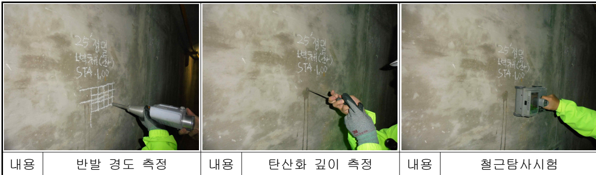
【사진 4.4】 송포일산인출 전력구 재료시험 전경
