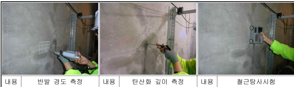
【사진 3.4】 문발SS인출 전력구 재료시험 전경
