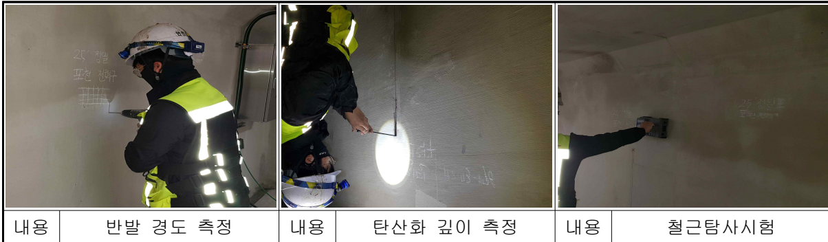
【사진 2.5】 포천인출 전력구 재료시험 전경
